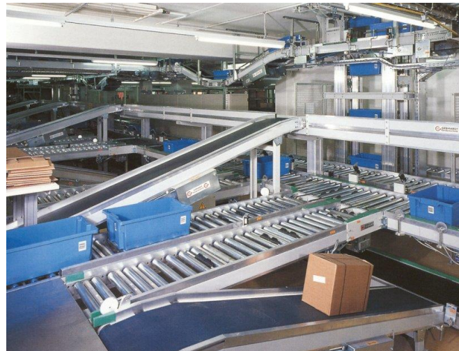
Behälterförderanlage im industriellen Bereich 40
